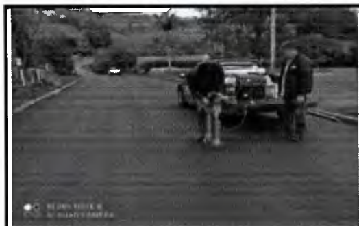
Serviço: Furo Sondagem
